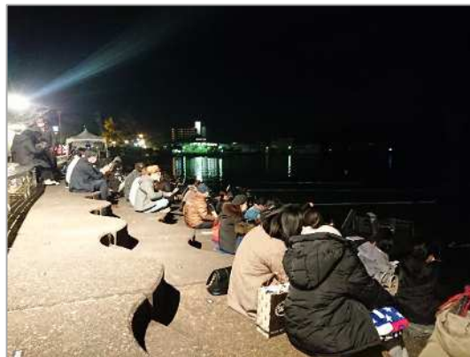
館山寺の階段護岸
