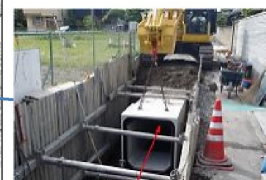
管渠工 沓谷排水区雨水渠
