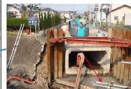
管渠工 高橋雨水ポンプ場放流渠
