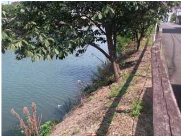
稚児橋上流の護岸の状況
