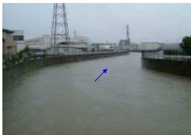
大谷川放水路 -葵区古庄-
