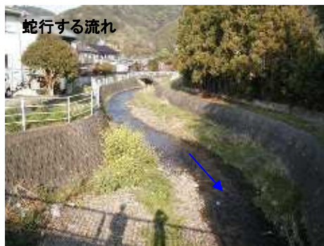
図 2-38 上流部の河道の状況 - 葵区北 -
