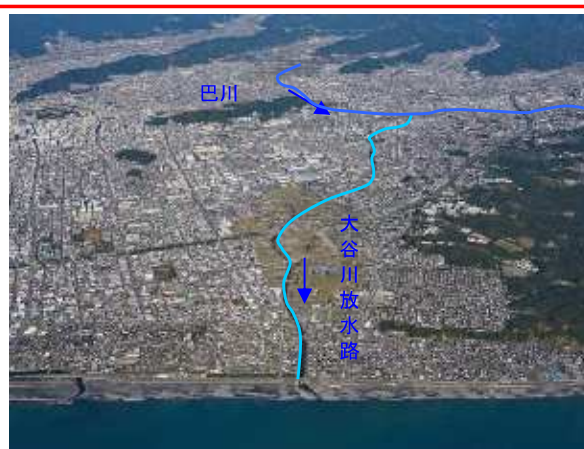
図 1-8 大谷川放水路全景
