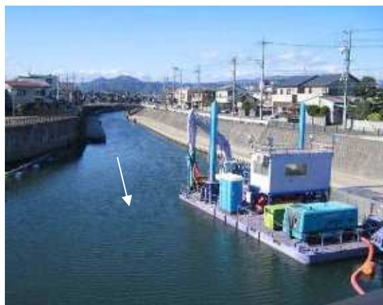
図 2-32 河川浄化の状況 (底泥の浚渫)
