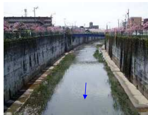
図 2-46 大谷川放水路の状況 - 駿河区小鹿 -
