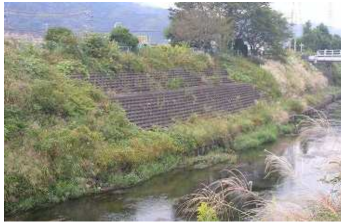
図 2-29 階段護岸の状況 -巴橋上流-
