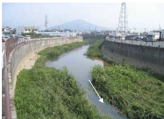
大谷川放水路 -葵区古庄 2 丁目
