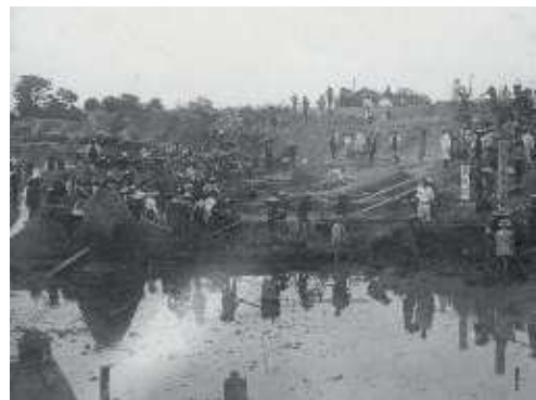
図 1-25 巴川の改修状況 -明治 43 年- 上土誌より転載
