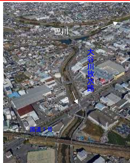
大谷川放水路分流堰 -葵区古庄-
