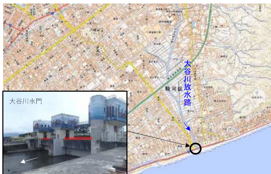
図 4-18 津波対策水門の設置箇所
