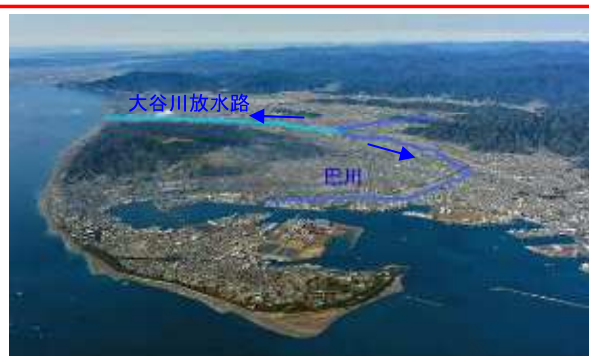
図 1-7 巴川下流部全景
