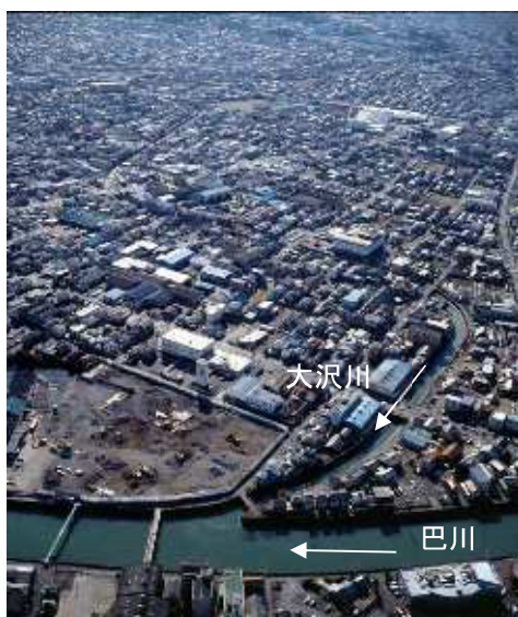
図 1-57 大沢川下流部 -清水区東大曲町付近-
