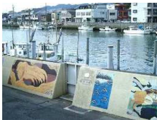
パラペット堤 -津波対策-
