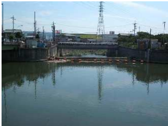
大谷川放水路分流工 -葵区古庄-
