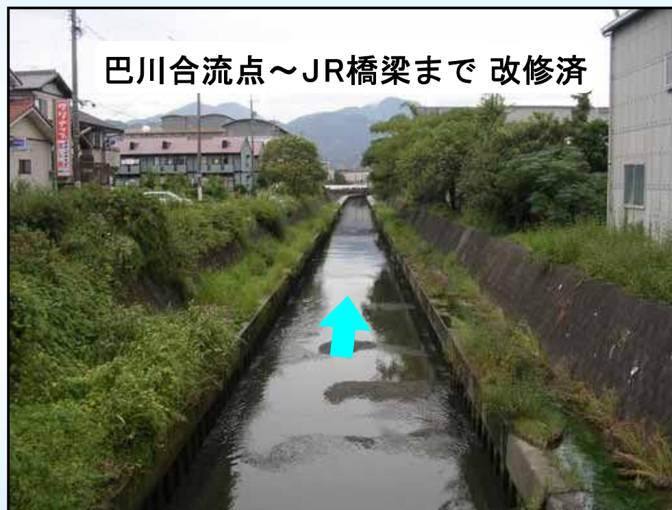
住宅地が連担する大沢川の状況 くぬぎ 櫓橋（清水区西大曲）
