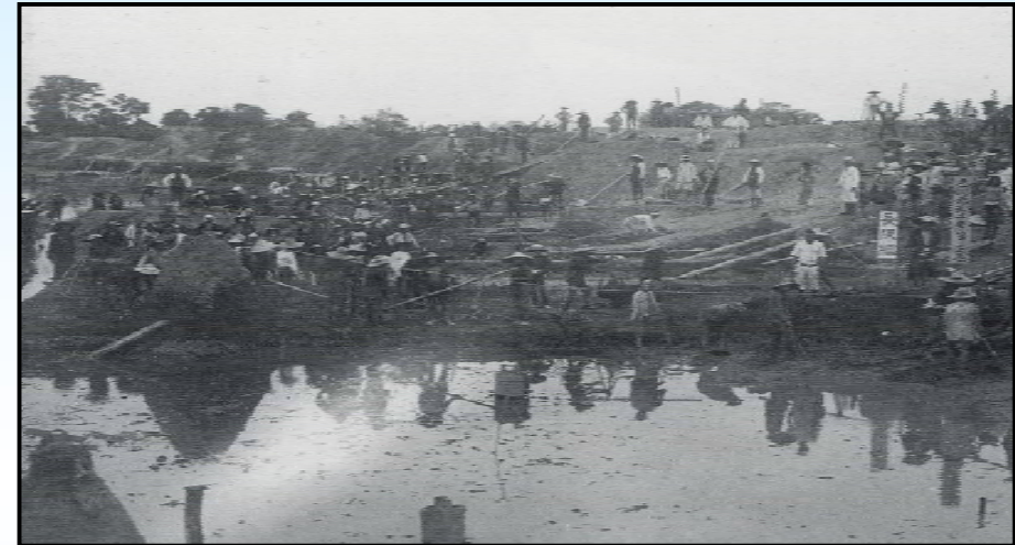
巴川の改修状況（明治43年）
