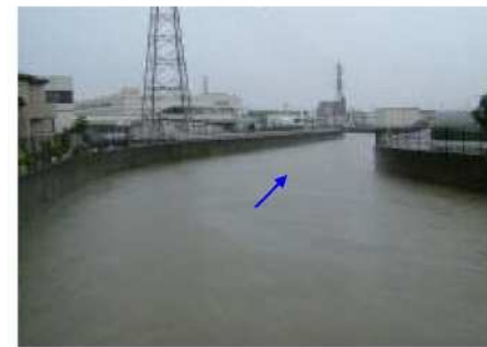
大谷川放水路 -葵区古庄-
