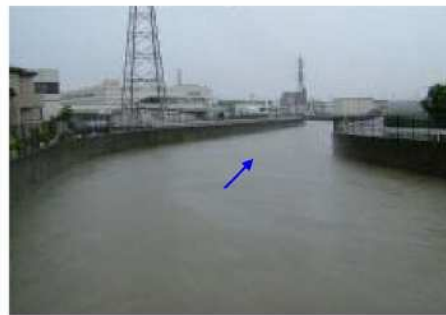
大谷川放水路 -葵区古庄-
