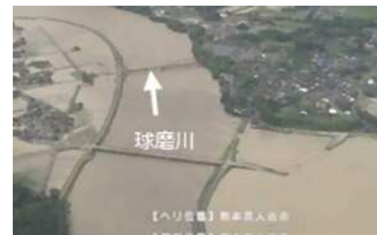
熊本県球磨川における浸水被害
