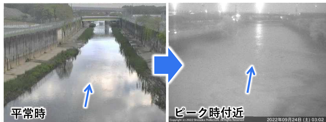
大谷川放水路の状況
