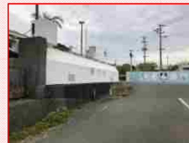
津波・高潮防災ステーションの整備
