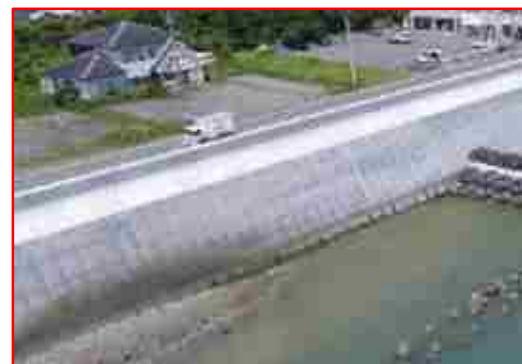
防潮堤の整備
