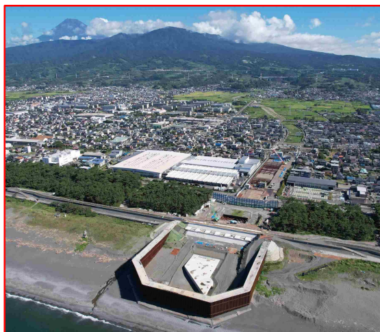
放水路の整備 ＜一級河川沼川〔沼津市〕＞
