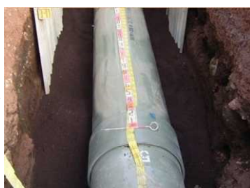
改修工事完了
