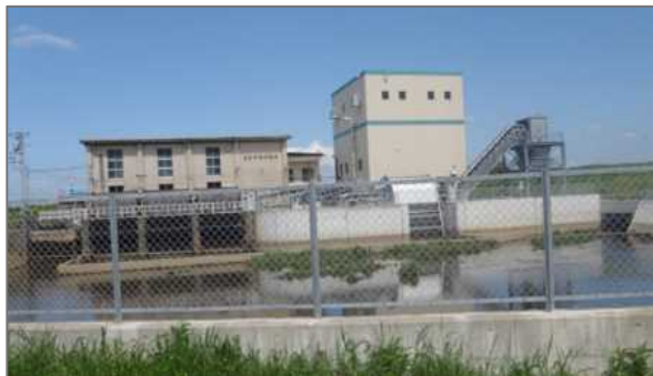
毘沙門排水機場(伊豆の国市)
