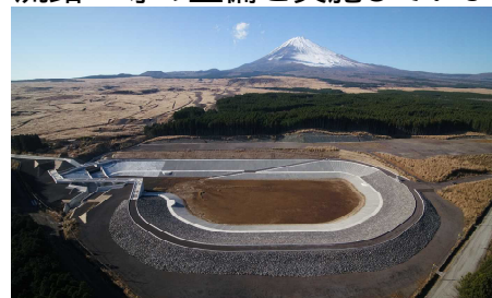
境沢川調節池
