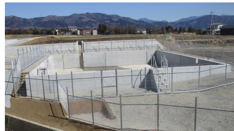
立沢川調整池
