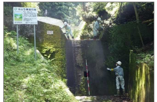
治山パトロールの様子(伊豆市)
