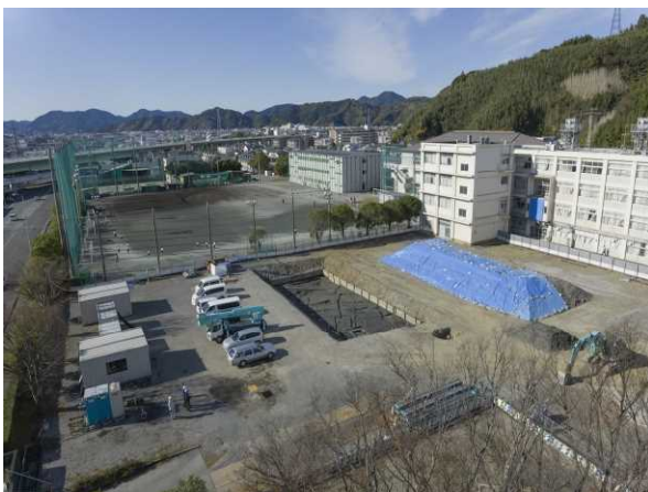
第3面全景（東から）
