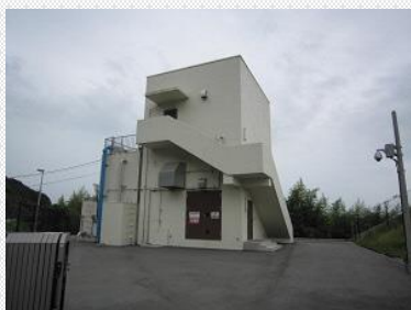
上野部ポンプ場（磐田市）
