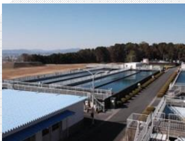
寺谷浄水場（磐田市）
