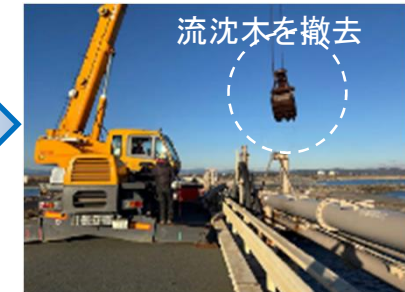
流沈木撤去を計画的に実施する
