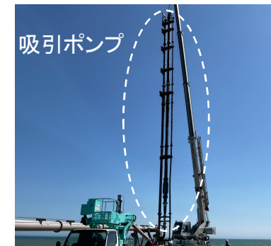
吸引ポンプを計画的に引き上げ、点検、メンテナンスする
