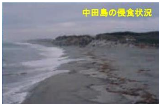
測線No. 160付近での侵食によるゴミの流出箇所(2004年)
