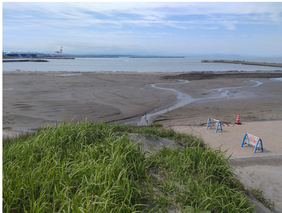
浚渫箇所の状況 2024年6月19日撮影
