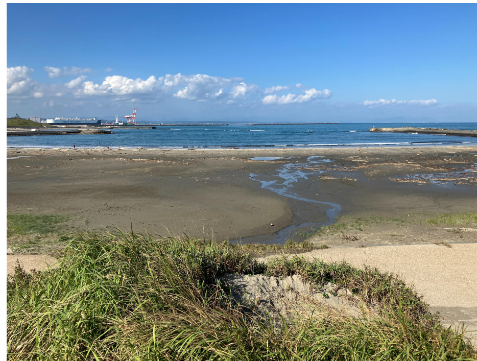
浚渫箇所の状況 2024年11月4日撮影
