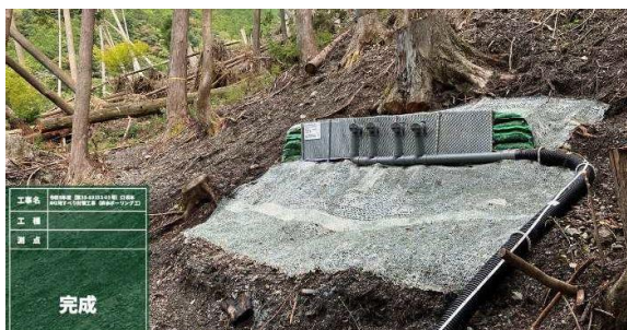
横ボーリング 完成状況
