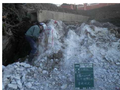
岩盤の露出に伴う岩掘削作業
