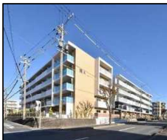
第1工区完成後
