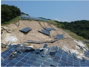
土砂崩れで生じた崩落
