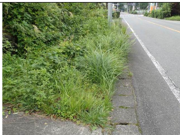
富士山スカイライン下り線区画 No. 5 (平成 29 年 9 月 20 日撮影)
