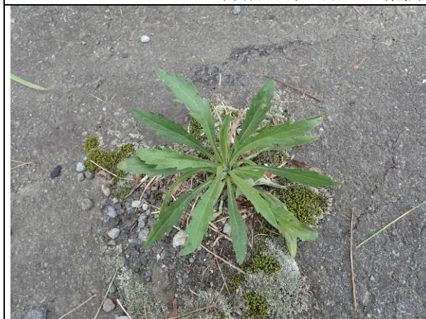
県道 23 号線上り線区画 No. 41 (平成 29 年 9 月 19 日撮影)
