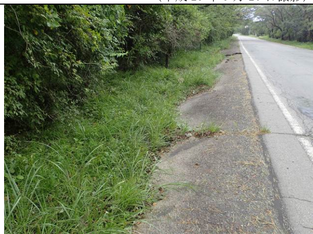
県道 23 号線上り線区画 No. 35 (平成 29 年 9 月 19 日撮影)
