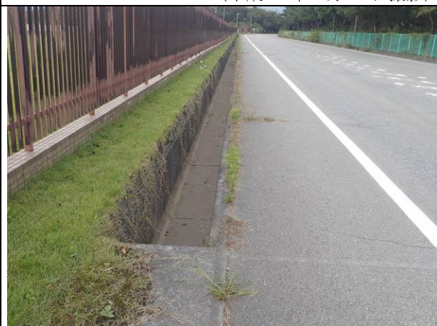
県道 23 号線下り線区画 No. 41 (平成 29 年 9 月 19 日撮影)
