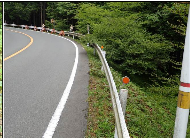
富士山スカイライン下り線区画 No. 44 (平成 29 年 7 月 6 日撮影)
