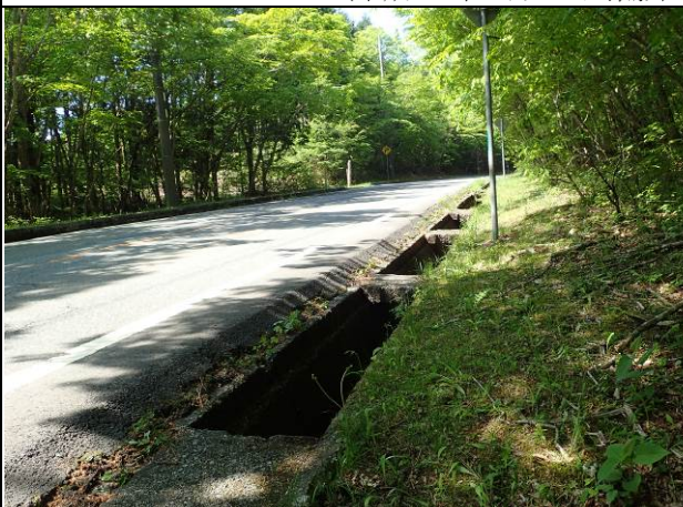
県道 23 号線上り線区画 No. 2 (平成 29 年 5 月 23 日撮影)
