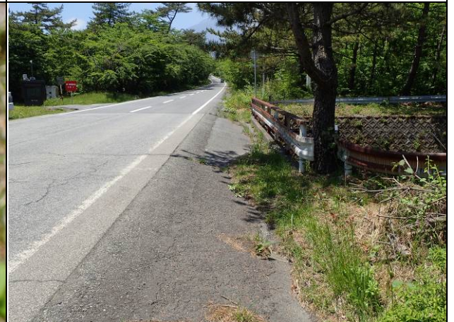
県道 23 号線上り線区画 No. 27 (平成 29 年 5 月 23 日撮影)
