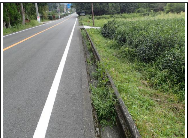
富士山スカイライン下り線区画 No. 3 (平成 29 年 9 月 20 日撮影)
