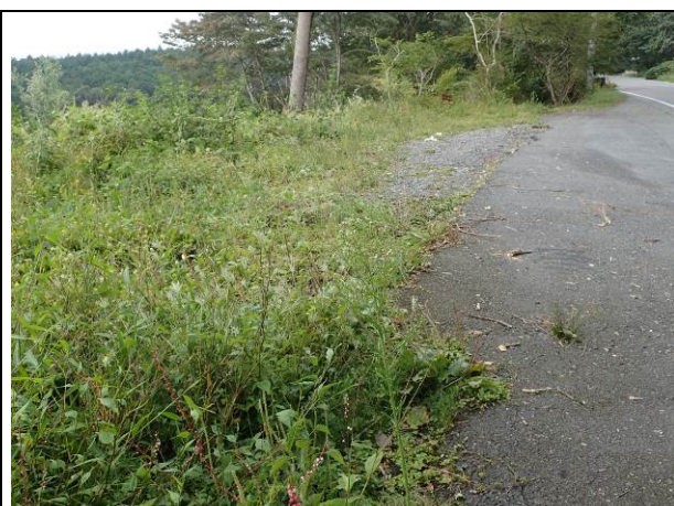
富士山スカイライン下り線区画 No. 32 (平成 29 年 9 月 20 日撮影)
