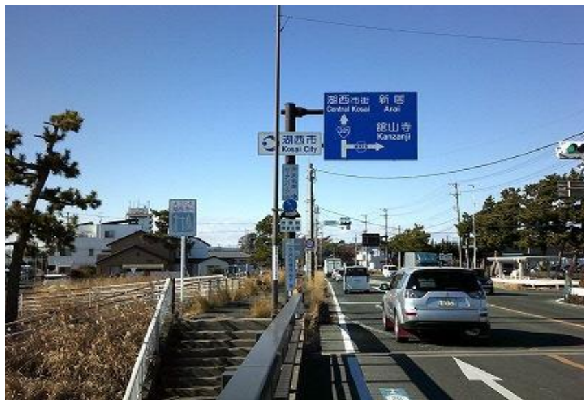
30 西進(国道301号下り線) 遠景
