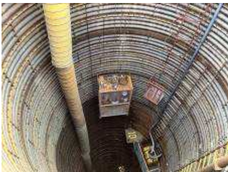
深層杭に工事用エレベーターでもぐったよ
