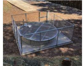
集水井工(ライナープレート)
