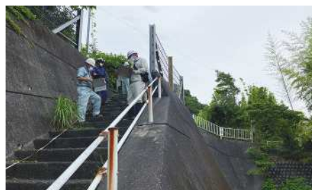
急傾斜地パトロール
