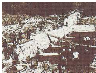
白田川(東伊豆町白田) 昭和13年度白田川砂防工事実施状況
