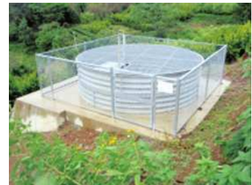
集水井工(ライナープレート)
