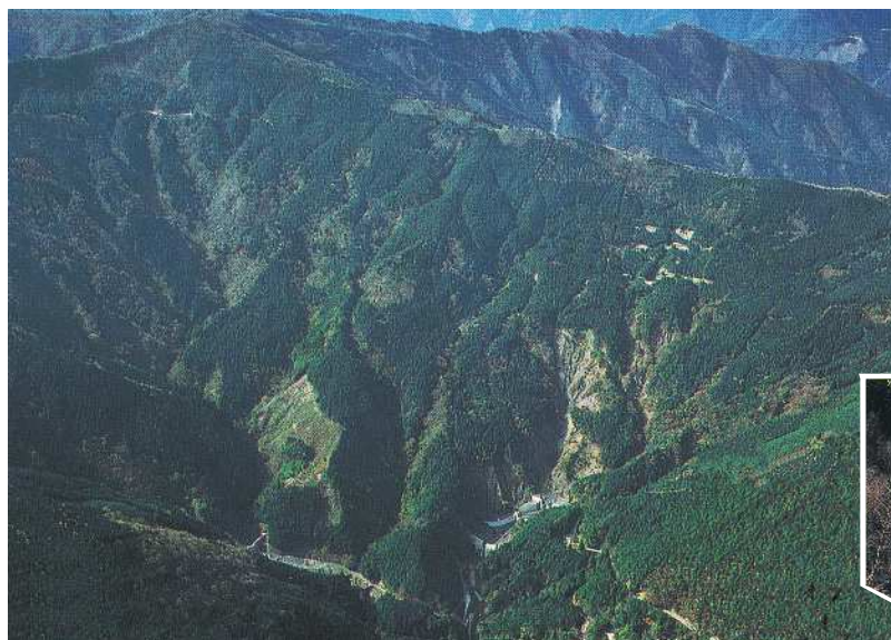
静岡市街を保全する大規模地すべり対策 口坂本地すべり(静岡市葵区口坂本)
