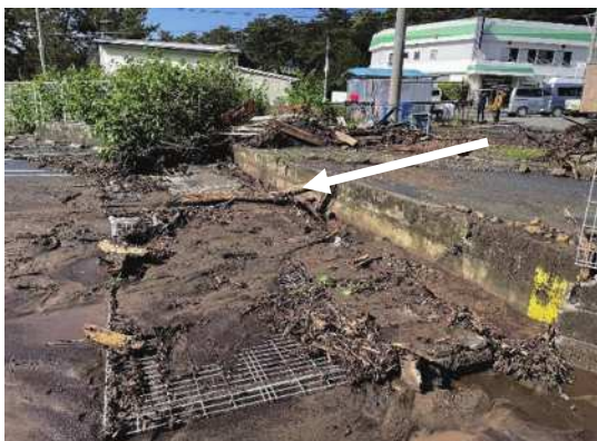
三堂川土砂流出状況
