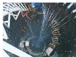
集水井内で地下水を 排除している状況
