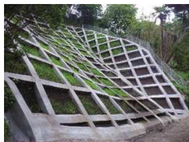
法面工事完成 (R6.6)
