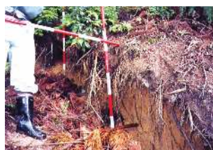
地すべり頭部の段差状況
