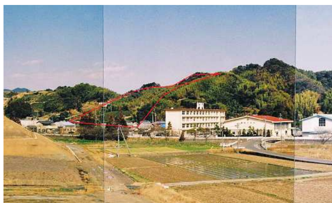
要配慮者利用施設や準用河川を保全する地すべり対策 ウスイ坂南地すべり(藤枝市中ノ合)
