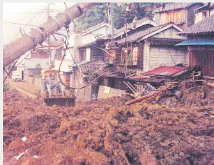
がけ崩れにより建物や電柱が損壊 (静岡市)
