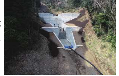
砂防堰堤の施工状況(令和5年2月27日)
