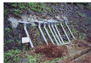
横ボーリング工
