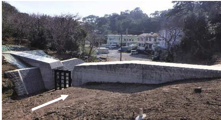
砂防堰堤工事完成 (R6.3)
