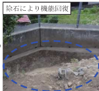
R7. 9月台風でも土砂を捕捉
