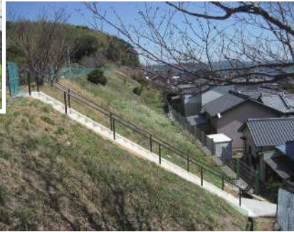
津波浸水区域内の急傾斜施設に設置された津波避難兼管理用階段
