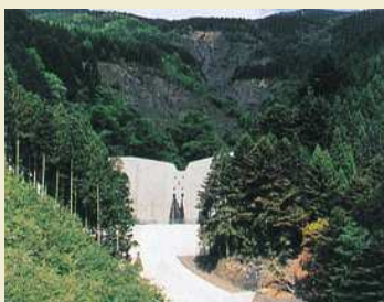
安倍川水系 龜久保沢 (静岡市葵区口坂本) 静岡県内最高の砂防堰堤H=26mL=81m (平成元年)
