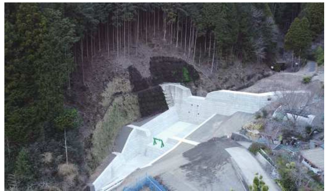
上有東木沢砂防堰堤(令和6年3月完成)
