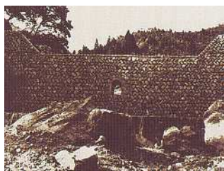
天竜川水系 翁川(浜松市天竜区水窪町) 昭和28年度砂防工事
