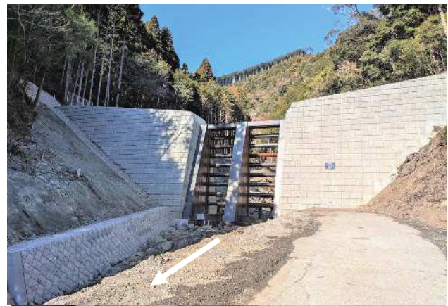
砂防堰堤工事完成 (R7.2)
