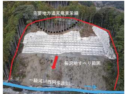
災害関連事業範囲の地すべり対策工事完成 (R7.3)
