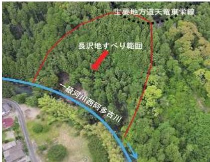
崩壊発生後斜面状況
