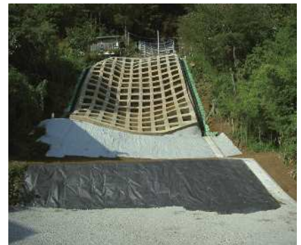
法面工事完成 (R7.12)
