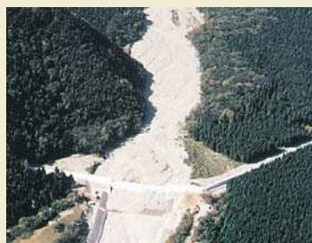
富士川水系 麓川 (富士宮市麓) 静岡県内最長の砂防堰堤H=6mL=262m (平成2年)
