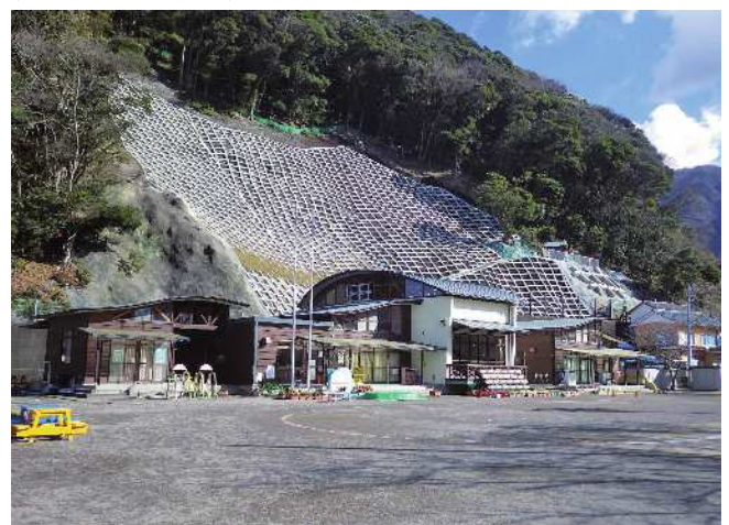
安里里向田No.3急傾斜地 (賀茂郡西伊豆町安里)
