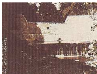
瀧川(東伊豆町奈良本) 昭和29年度砂防工事
