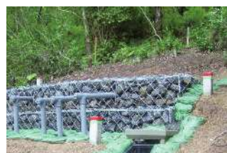
横ボーリング工
