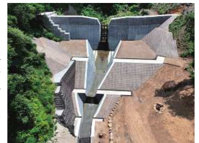
松沢川第2砂防堰堤(令和7年6月完成)
