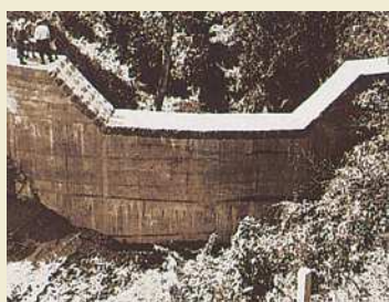
富士川水系 廻沢 (富士宮市内房) 静岡県初めてのアーチ式砂防堰堤 (昭和28年)
