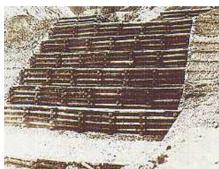
大井川水系 切山沢(島田市川根町家山) 昭和9年度(災害)切山第2号木工堰堤
