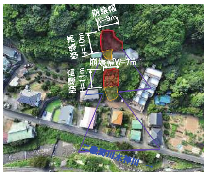
崩壊発生状況（全景）
