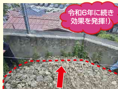
R7.9台風第15号でも土砂を捕捉
