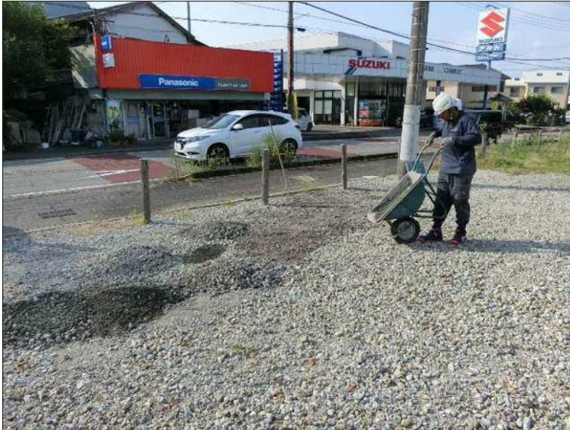
是正状況 碎石補充
