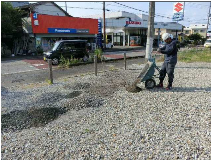
是正状況 碎石補充
