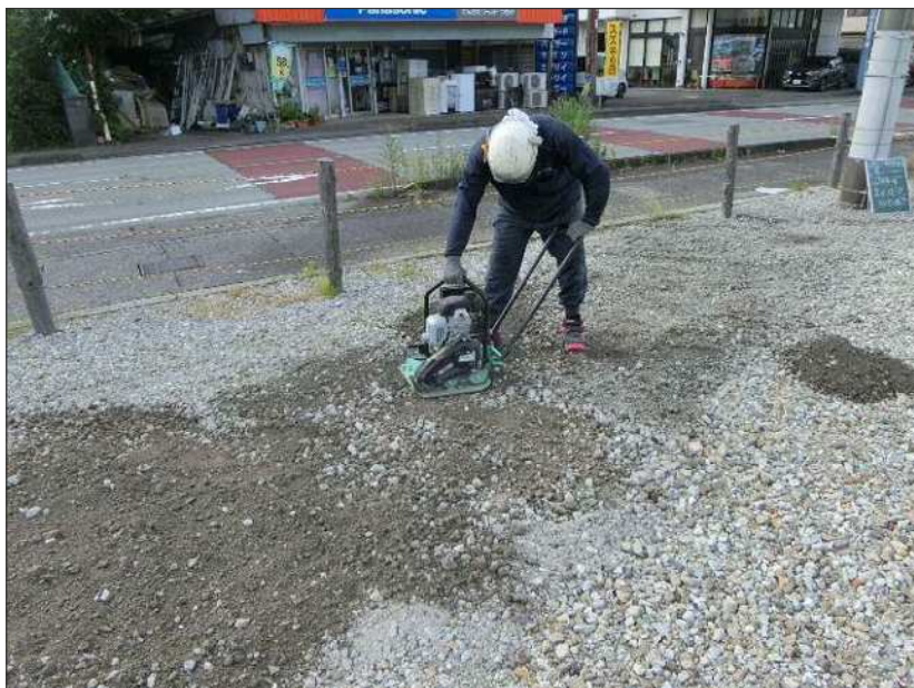
是正状況 碎石転圧
