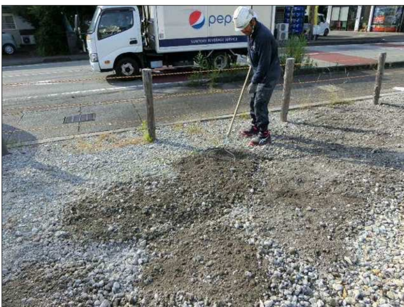
是正状況 碎石敷均し
