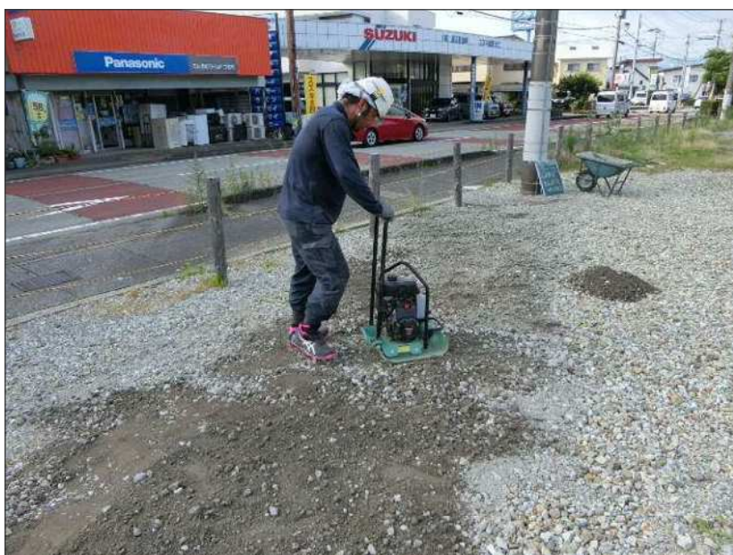
是正状況 碎石転圧
