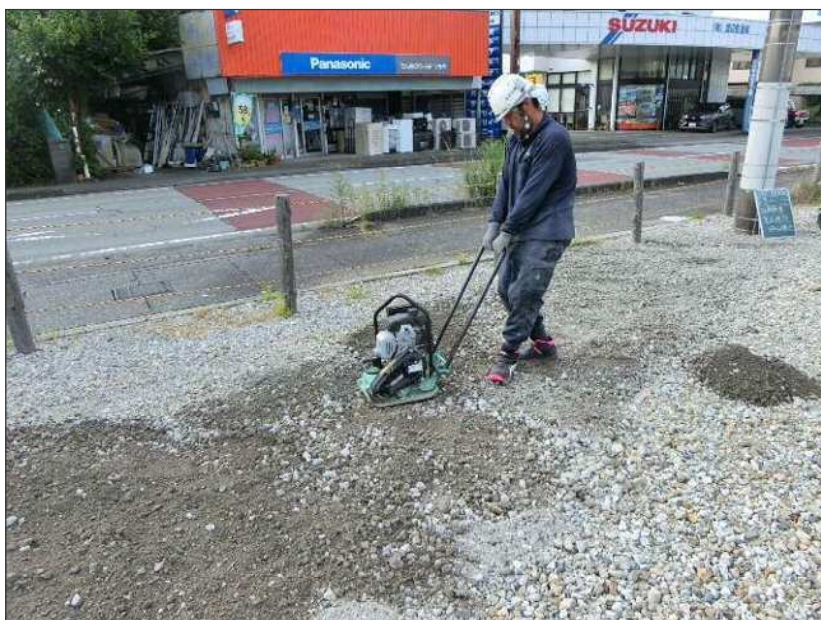
是正状況 碎石転圧
