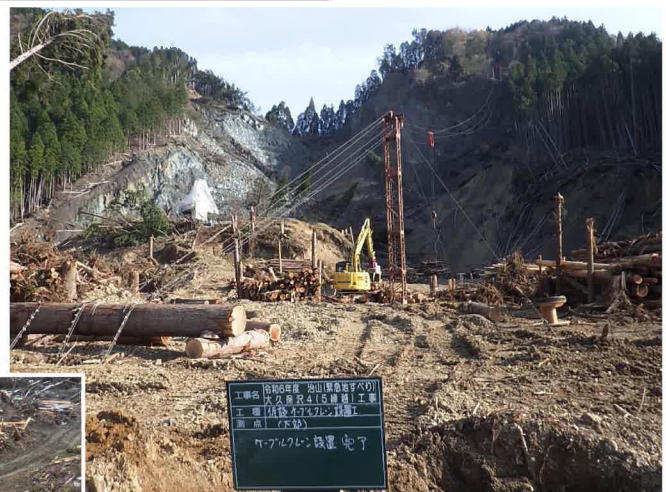
ケーブルクレーン運搬
