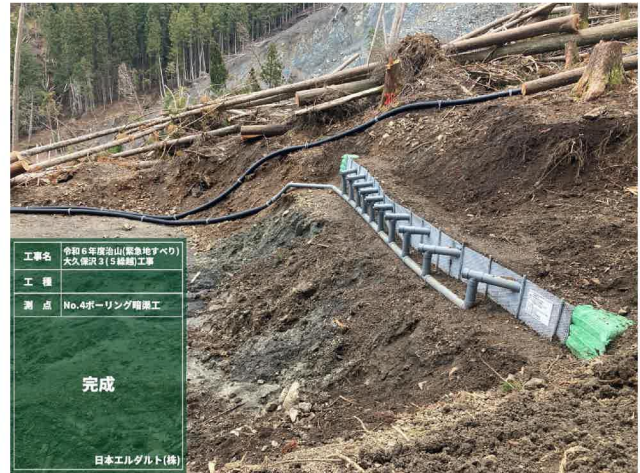
集水ボーリング暗渠工 (R6-4)
