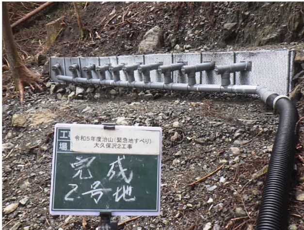
集水ボーリング暗渠工 (R5-2)
