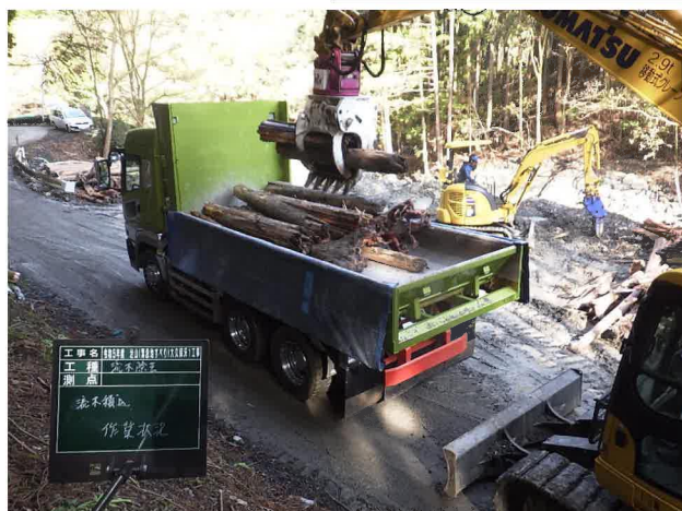
流木除去工（積込・搬出）
