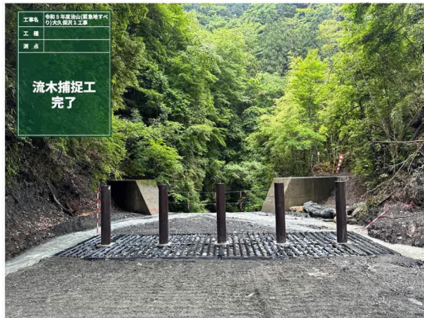
流木補足工 (R5災害関連緊急地すべり)
