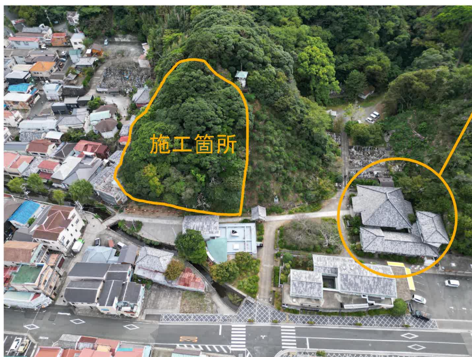
了仙寺敷地内の斜面
