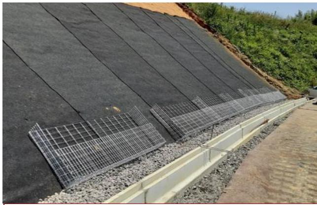
吸出し防止材設置、本体組立(上蓋半分設置)
