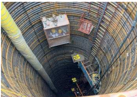
工専用エレベーターで深礎杭の中を 30mの深さまでもぐったよ
