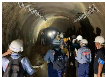
排水トンネルで地下水を抜く状況を確認したよ
