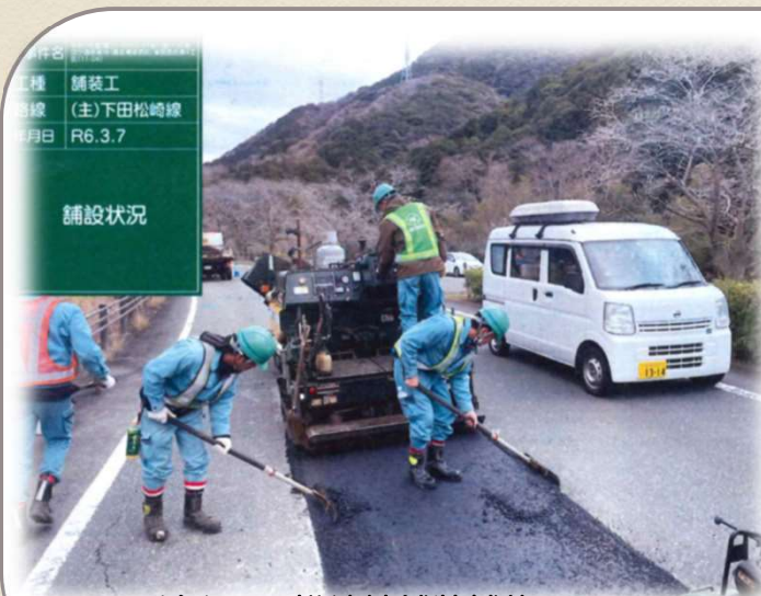
(主) 下田松崎線舗装補修 舗設状況
