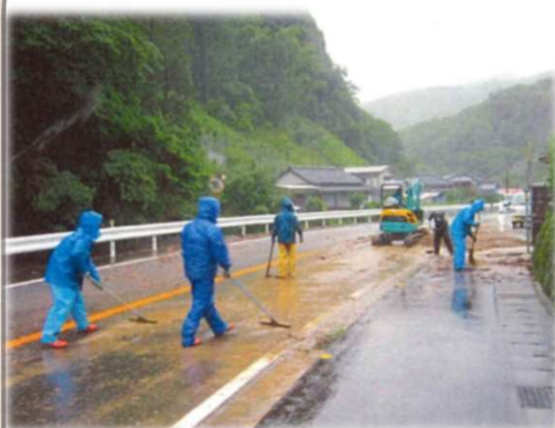
下田松崎線流入土砂撤去作業
