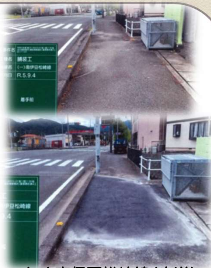
(一) 南伊豆松崎線(歩道) 舗装補修(水たまり解消)
