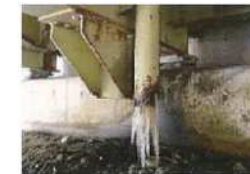
写真-4 排水管路末処理の不良事例
