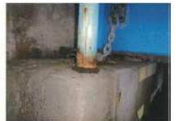
写真-4 排水管路末処理の不良事例
