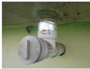
図 7.4 点検時の簡易補修の例②
