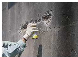
図 7.3 点検時の簡易補修の例①
