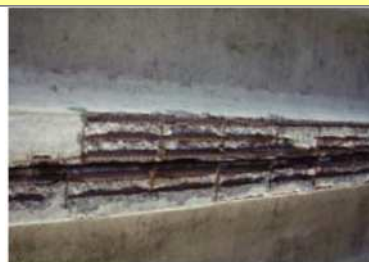
床版（補強材の再劣化）
