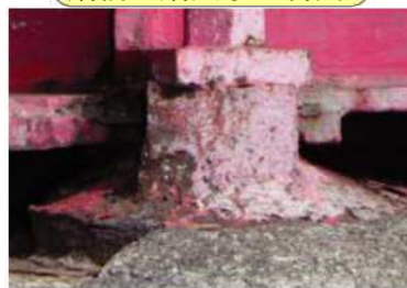
鋼橋（鋼支承の腐食）
