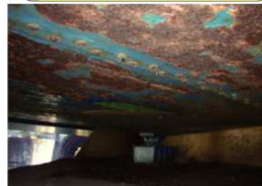
床版（補強材の再劣化）
