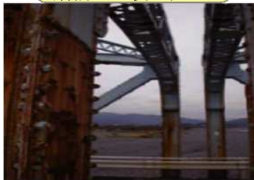
鋼橋（鋼支承の腐食）
