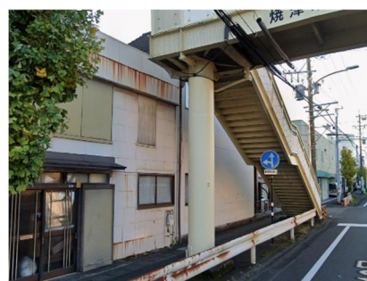
図-7.8 歩道幅員が確保できない例
