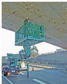
橋梁点検の様子
