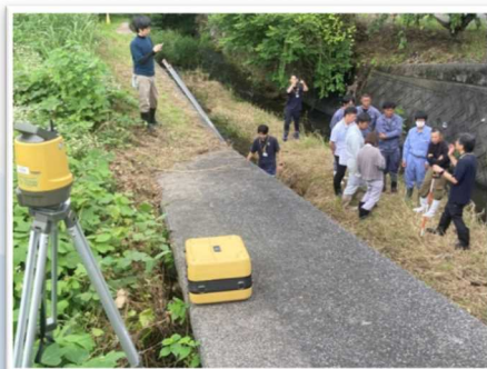
TSを用いた現地計測・出来形管理
