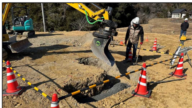
バケットの角度および回転を調整しながら基礎砕石を投入・敷き均し（作業員1名にて敷き均し作業を実施） MG機能で高さを確認
