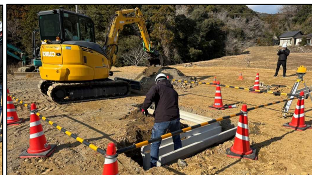
手元作業員1人で埋め戻し作業
