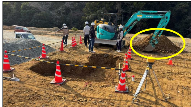
床掘の掘削量が増加
