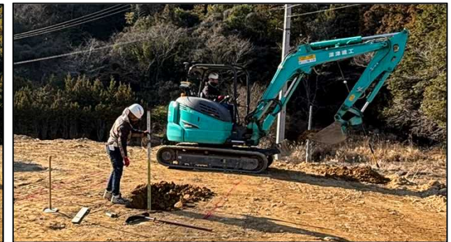
作業員がレベルで高さの確認
