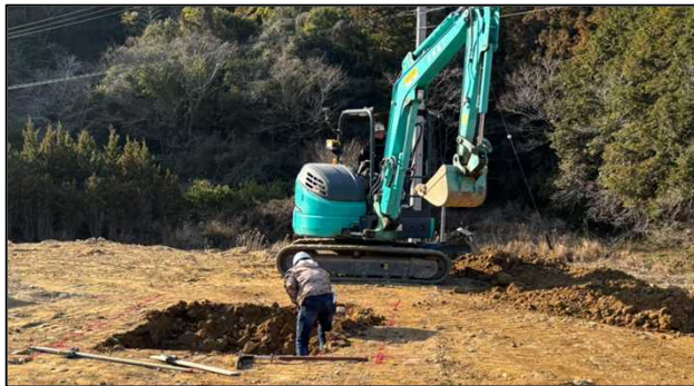
隅角部など建機による施工が難しい部分は作業員が手作業で施工
