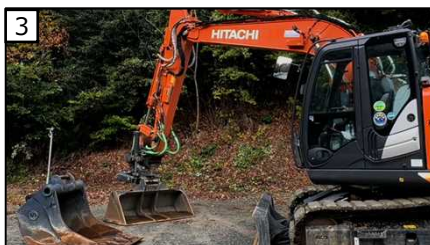
3 バケット取り付け作業 (オペレータ)
