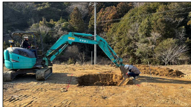
施工面に正対するため、機体を移動させながら施工
