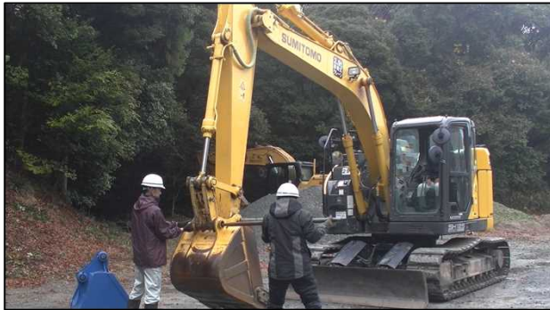
バケットを接合している ピンの取り外し作業
