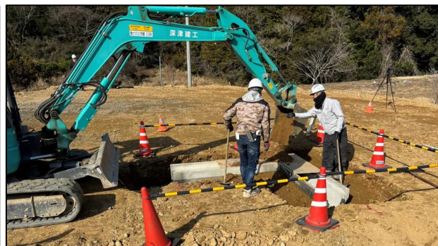
構造物設置後、コンパネを構造物上に設置し、 建機を用いて埋め戻し作業 (作業員が建機で対応できなかった部分の埋め戻し作業)
