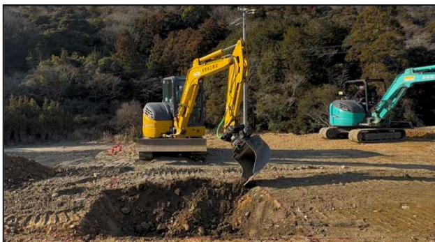
隅角部などはバケットの角度および回転を調整しながら施工
