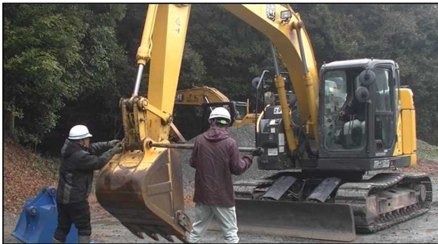
バケットを接合している ピンを取り外し作業
