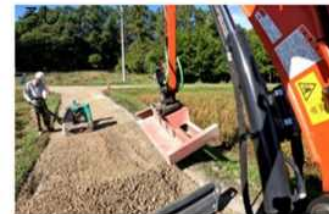
グレーティングバケットによる敷き
