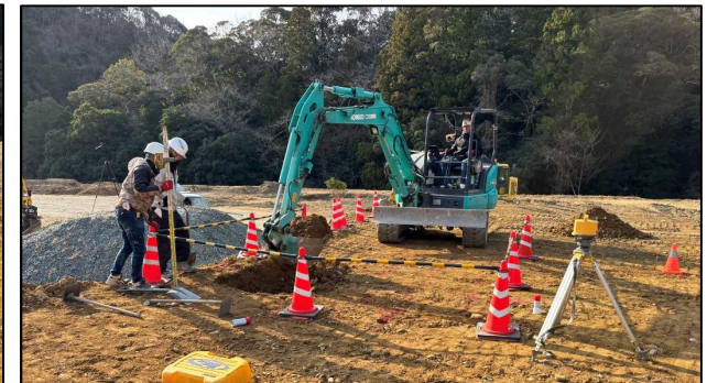
作業員がレベルで高さの確認
