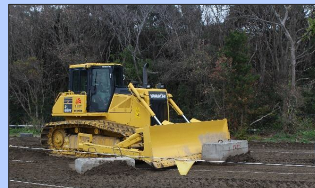
瓦礫撤去訓練
