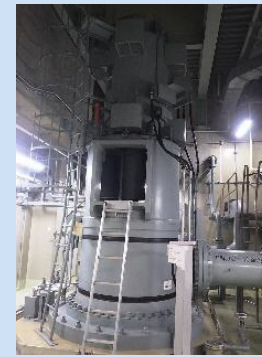
低圧注水設備（モータ駆動）
