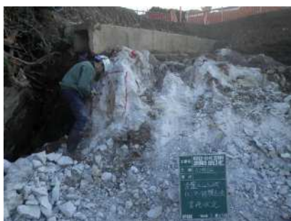
岩盤の露出に伴う岩掘削作業
