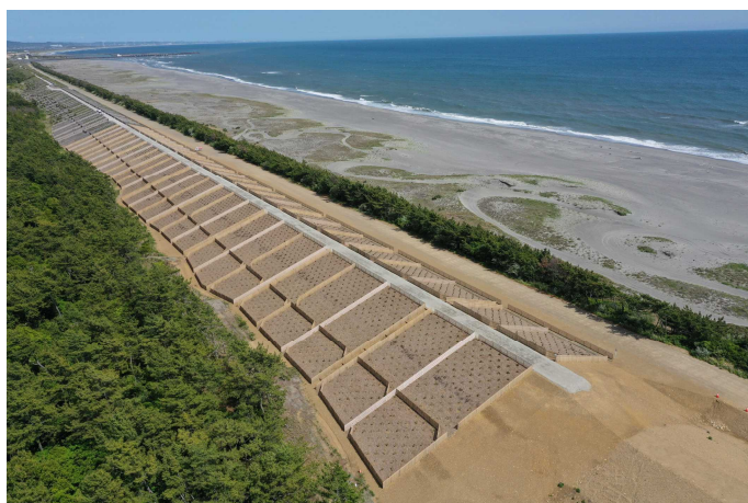
写真4 森の防潮堤づくりの防災林造成
