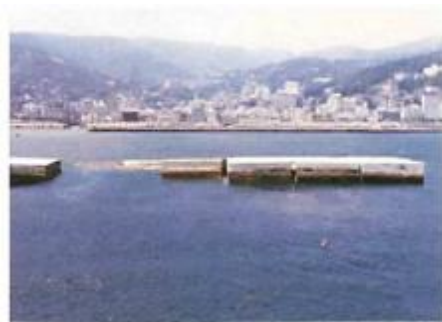
1982 年台風 10 号による 防波堤被害が生じた熱海港（熱海市）
