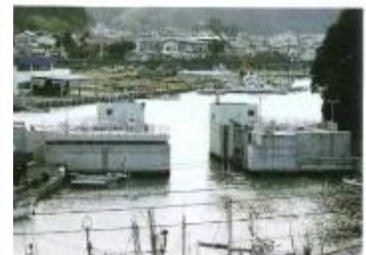
船溜前面に設置した水門 (西伊豆町)
