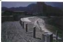
堤防の嵩上げとともに傾斜堤に改良 (松崎町)
