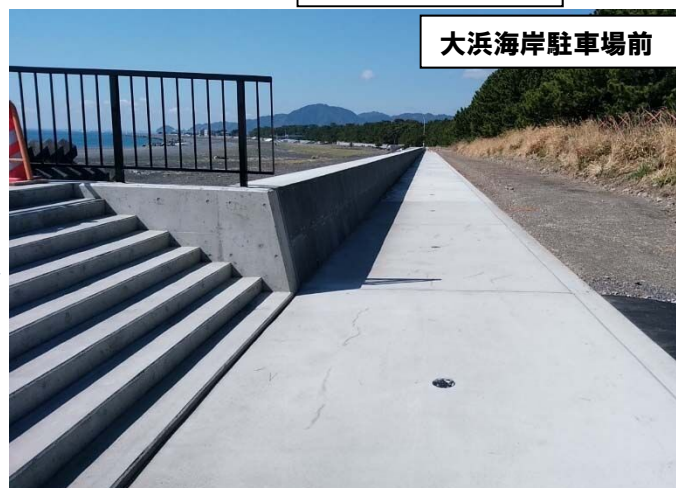
下島～西島地区(陸側) 完成
