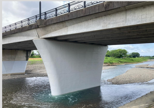
橋脚補強 (県道浜北袋井線 袋井市)
