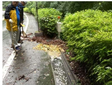
道路施設の異常
