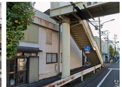
歩道幅員、視認性の阻害
