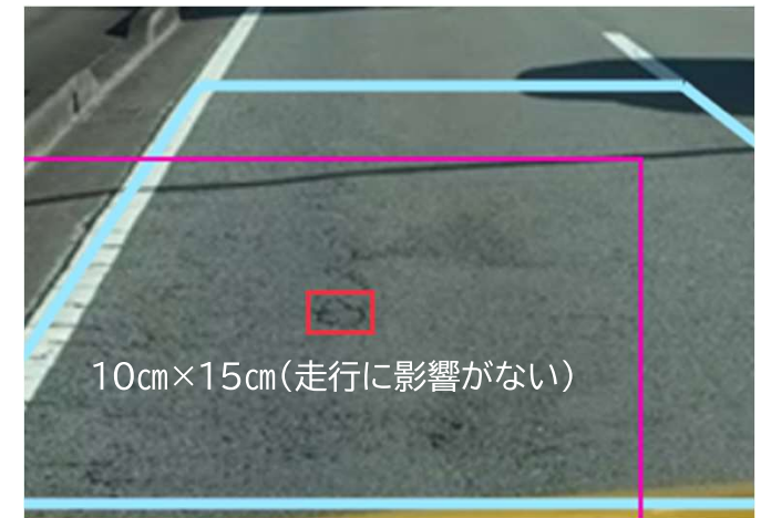
AIが検知した路面変状(穴ぼこ)
