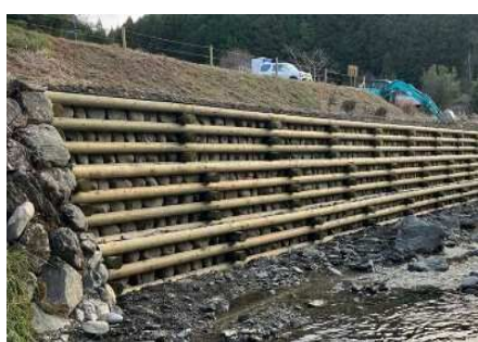
木柵護岸工(浜松市)
