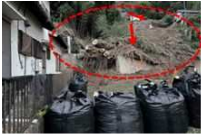
浜松市天竜区渡ヶ島 「渡ヶ島禿石（かぶろいし）」 （上空及び斜面下部より）【斜面高30m、崩壊幅25m、約500m 3 の土砂を捕捉】
