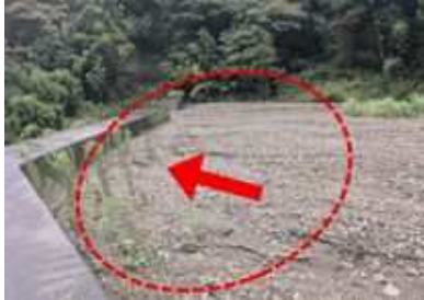
静岡市駿河区青沢 「殿谷川砂防堰堤」（全景） 【約2,000m 3 の土石流を捕捉】
