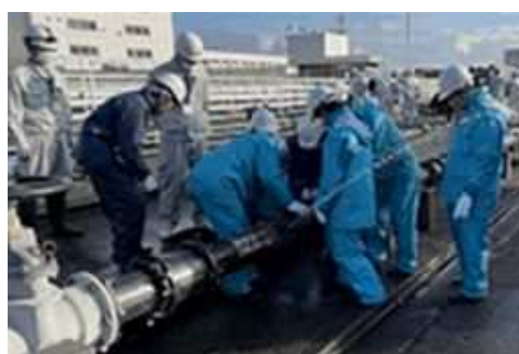
漏水復旧訓練の様子
