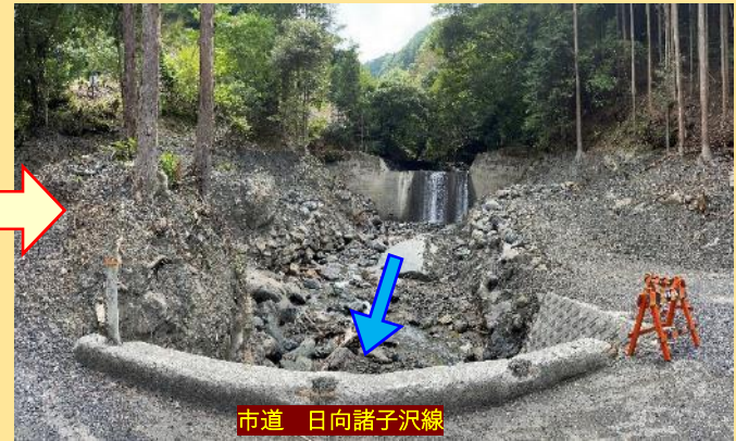
渓流内堆積土砂・流木撤去 (本工事)
