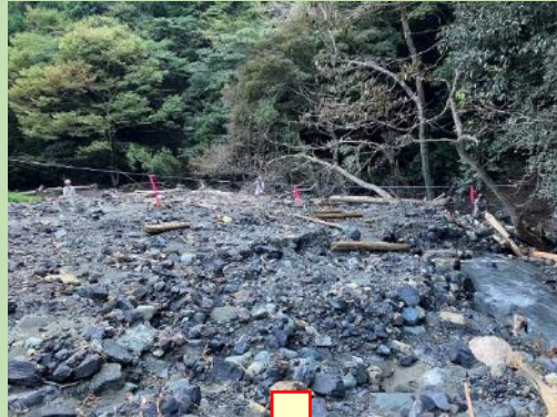
諸子沢川堆積土砂・流木撤去 (静岡土木・静岡市)
