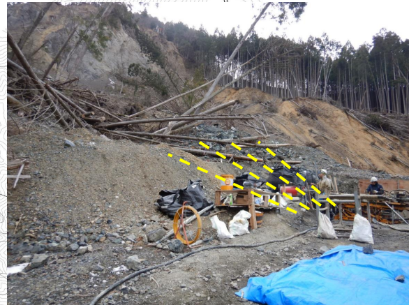
③R7 (6補正) ボーリング暗渠工 (R8.1.15撮影)
