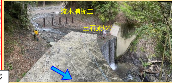
渓流内堆積土砂・流木撤去 流木捕捉工・土石流センサー設置 (本工事)
