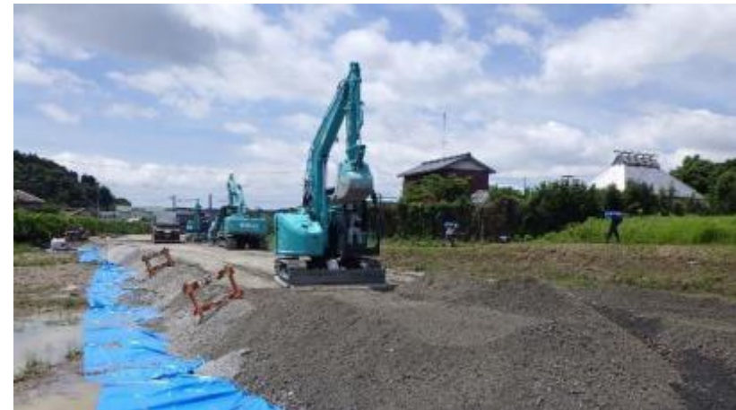
搬入された土砂を利用した工事用道路の整備状況
