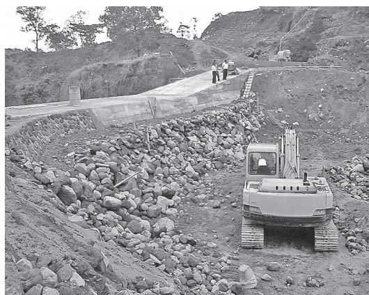
写真2 施工中のソイルセメントえん堤 (ゲンドール川)
