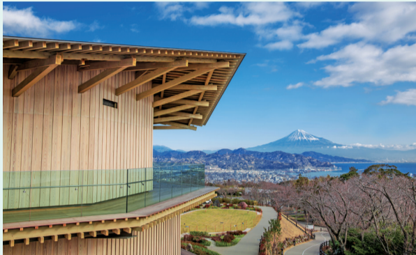
日本平シンボル施設 (日本平夢テラス)
